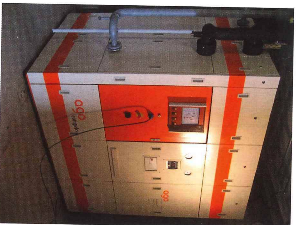
Bild 3: Ansicht der Ammoniak-Wasser-Absorptionskälteanlage Typ „congelo 50“ der Fa. AGO AG links mit und rechts ohne Einhausung
