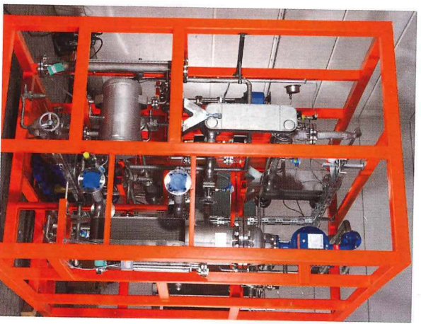
Bild 3: Ansicht der Ammoniak-Wasser-Absorptionskälteanlage Typ „congelo 50“ der Fa. AGO AG links mit und rechts ohne Einhausung
