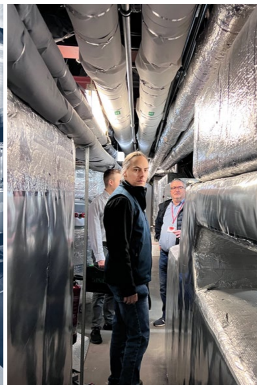
Begutachtung Anlagendämmung
