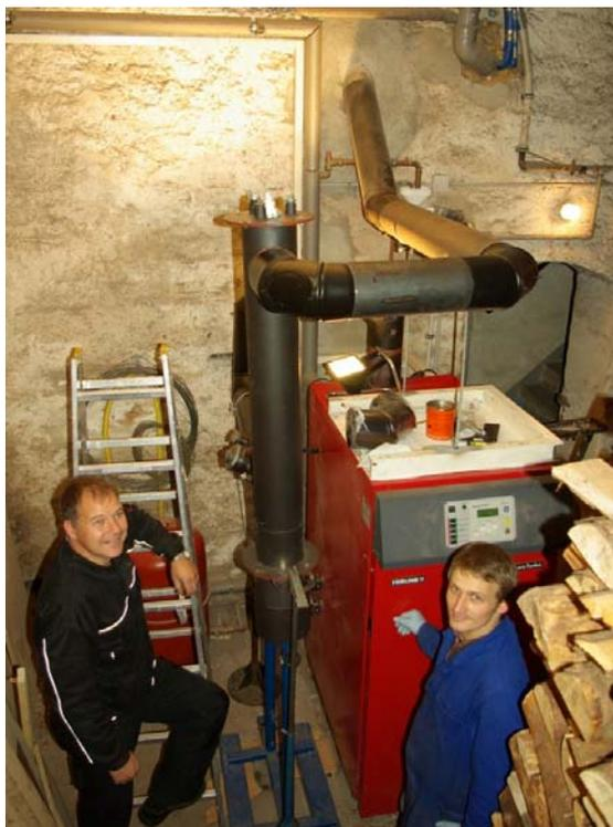
Bild 1: Aufstellung des Abscheiders in einem Privathaushalt bei der Inbetriebnahme durch den Bezirksschornsteinfegermeister
