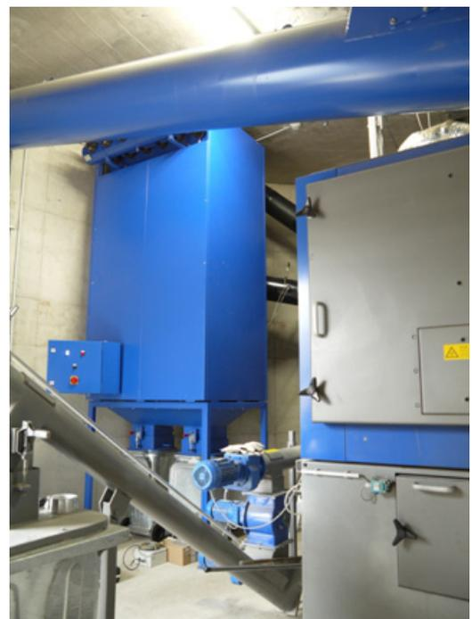
Bild 3: Feuerungs- und Filteranlage
