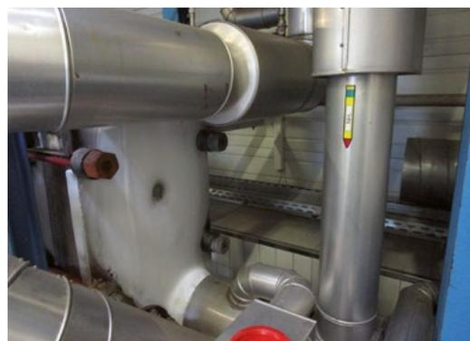
Bild 2: Versuch zur Kältemittelverteilung durch Vereisung
