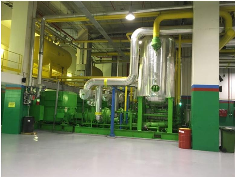
Kältemaschinen mit Kältemittel R717
