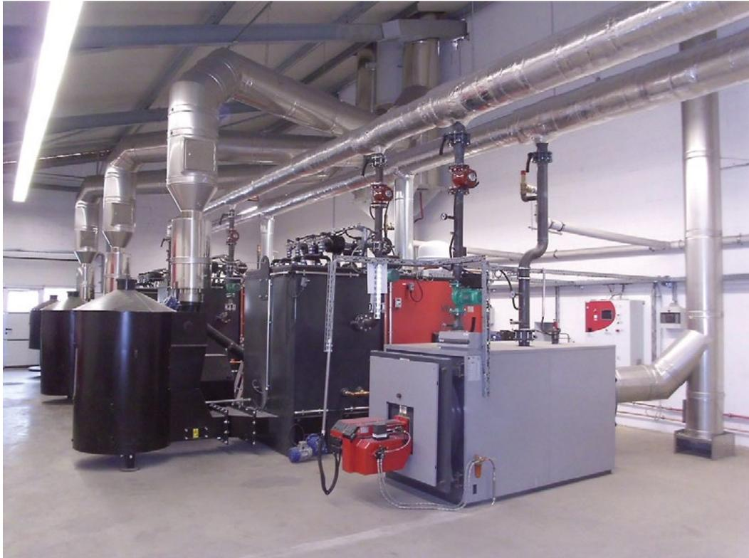
Das Ziel dieses Verbundprojektes mit der Firma Lange & Typky KG ist die Entwicklung, der Bau und der Test eines Systems aus Biomasseheizkessel und ORC-Anlage.
