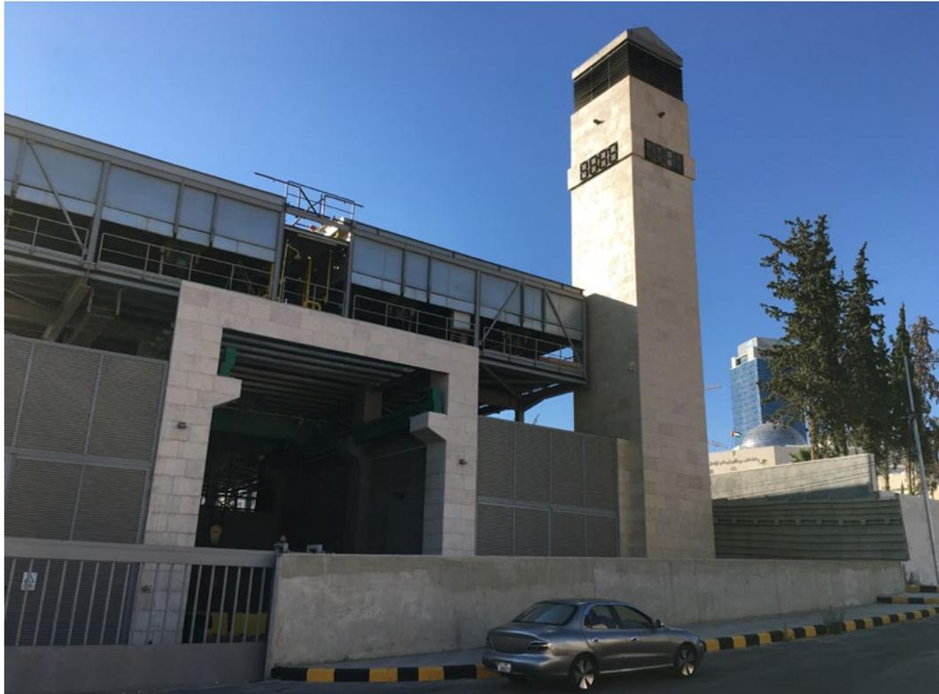
Außenansicht der Energiezentrale mit Rückkühlern auf dem Dach
