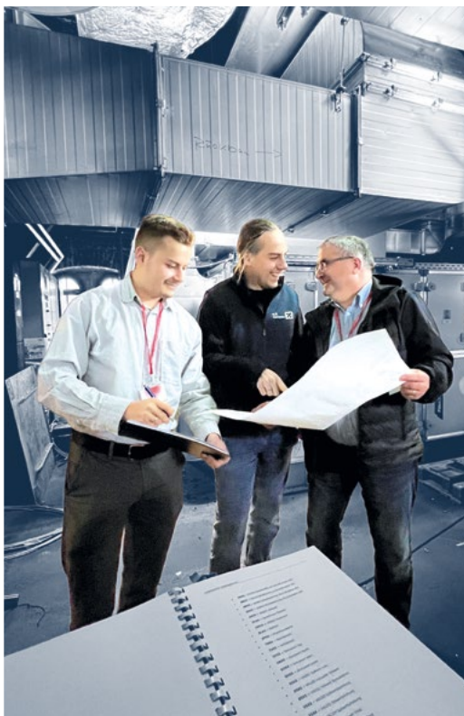
Abnahmetermin in der RLT-Zentrale
