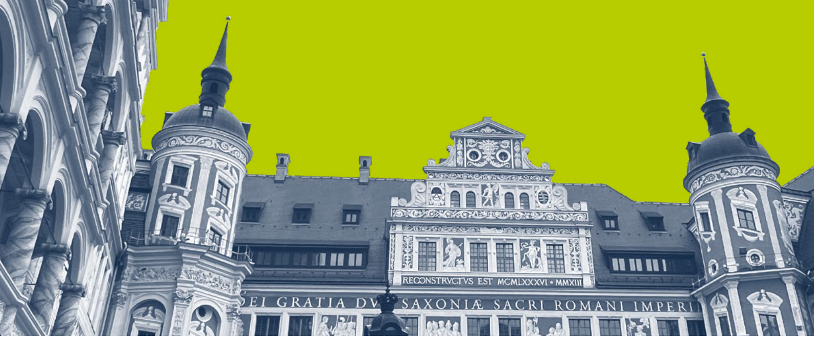
Fassade des Westflügels im Großen Schlosshof, hergestellt in der Technik des Sgraffito (Aufputzkratzen mit Kalkfarbe)
